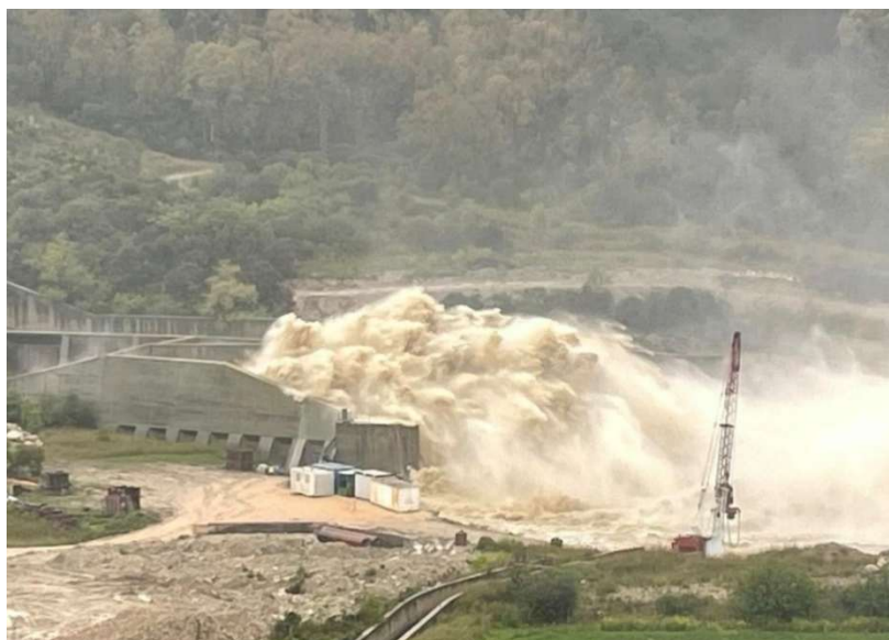
Figura 54 - Diga di Ponte Liscione alla massima portata dallo scarico di fondo, 525 mc/s. @Foto dal web.
