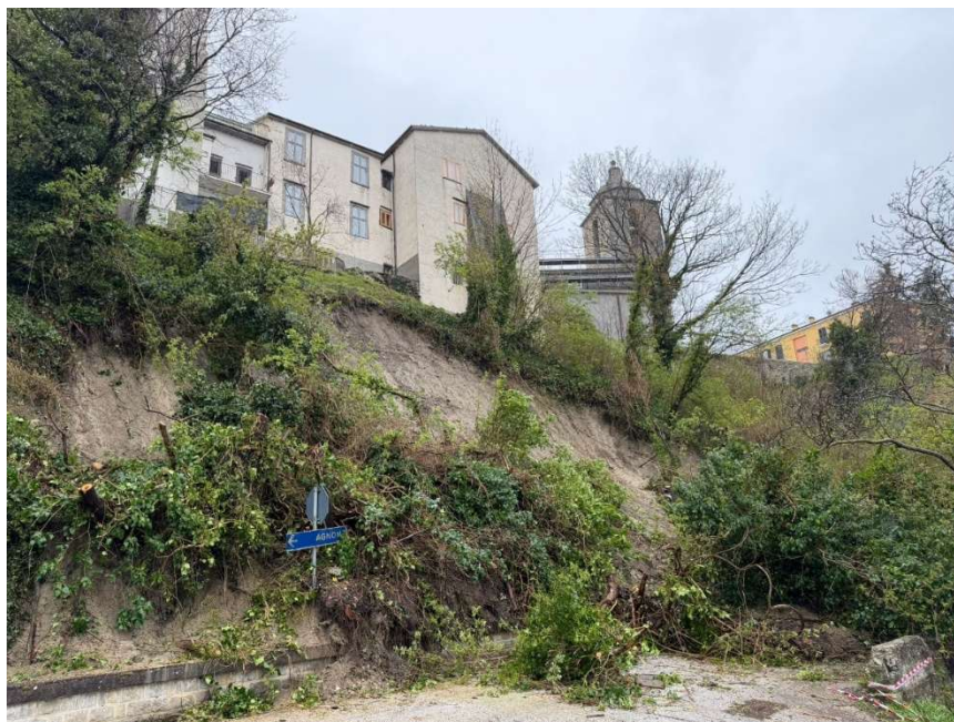
Figura 61 - Dissesto idrogeologico centro abitato di Agnone. @Foto Comune Agnone.
