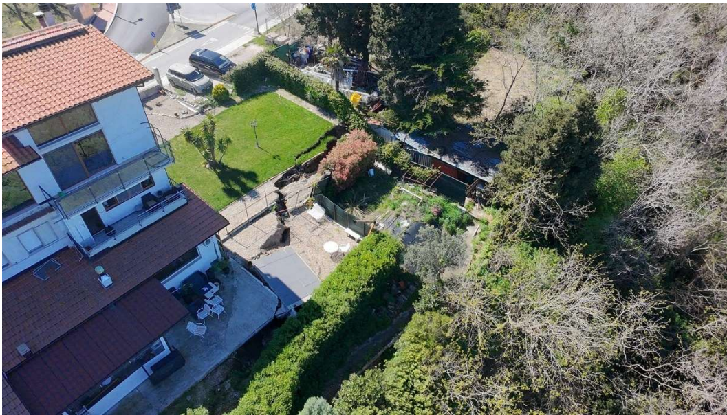
Figura 14 - Frana di Petacciato - Centro abitato
